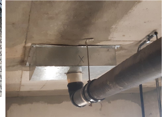
EMBUDOS UBICADOS EN EL TECHO DE LA PB
