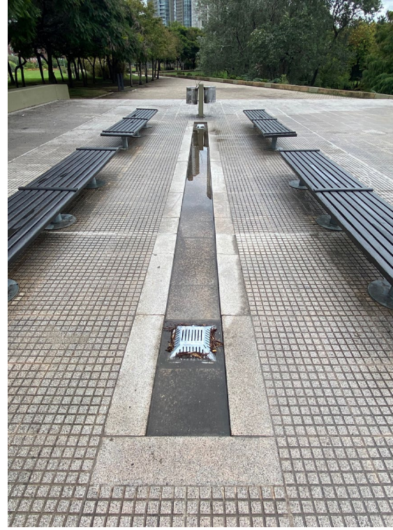
CANALETA ABIERTA EN TERRAZA
